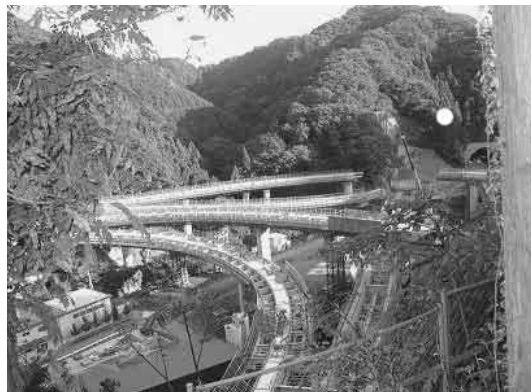
高尾山トンネル南孔口の工事現場
