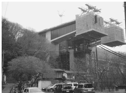
高尾山トンネル北孔口の工事現場
