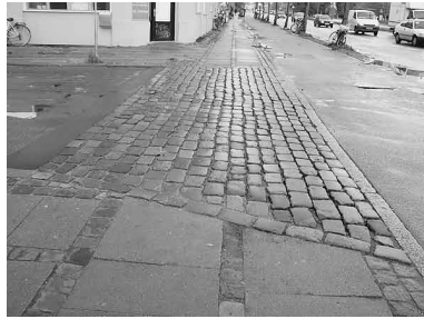
写真14 歩道プラトー
