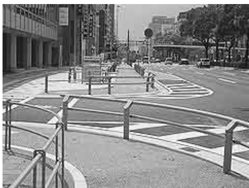
(図5) 国道19号(名古屋) 名古屋の自転車道はガードレールの中で双方向通行させているらしい
