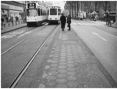
写真4 1車線一方通行の駅前大通り
