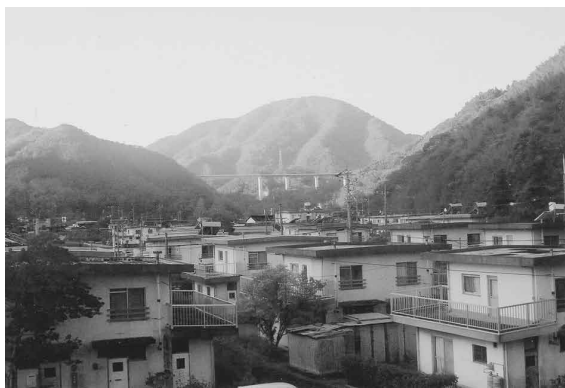
「萩・三隅道路」の橋脚が山の麓に伸びています
