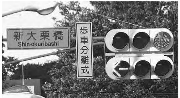
【写真2】2段式信号と歩車分離信号プレート
