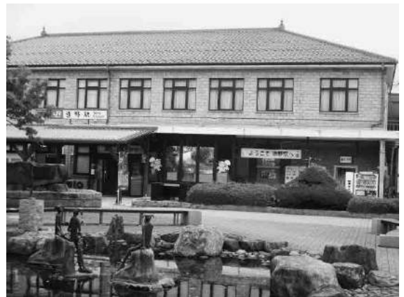
JR遠野駅—コンクリートブロックづくりで瓦屋根の駅舎。珍しい駅舎である。
