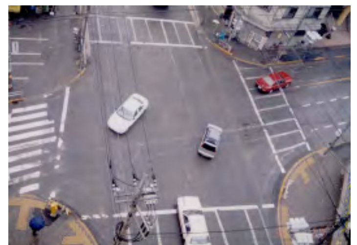
交通量が多く、消えかかった横断歩道
