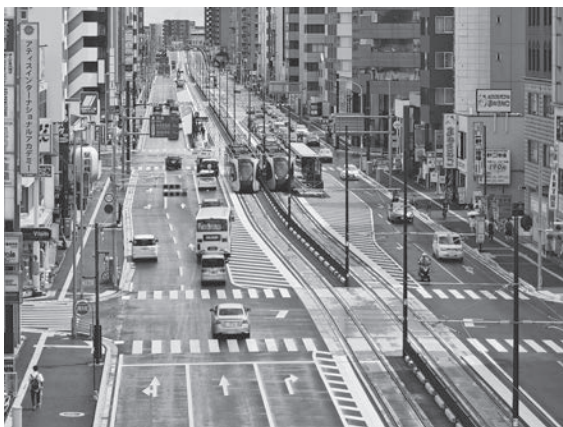
「鬼怒通り」に新設された線路と、東宿郷停留場付近を走る電車（開業翌日） 写真右端のビルは「祝LRT開業」の垂れ幕を掲げて祝っていた
