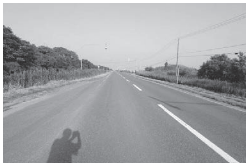
写真① 苫小牧から日高方面へ直線道
