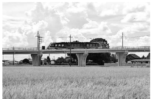
高架橋を走る電車(飛山城跡停留場付近)
