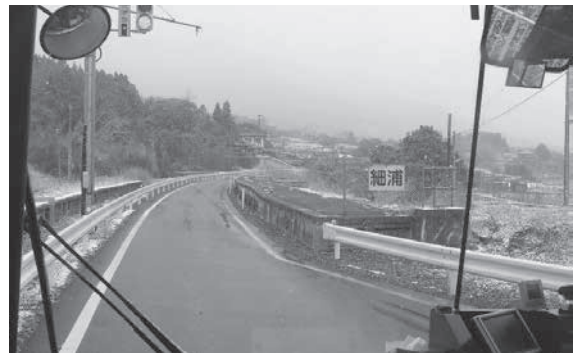
大船渡線BRT かつての線路にバス専用道が設けられている 写真の細浦駅には、両側に鉄道時代のホームが残っている
