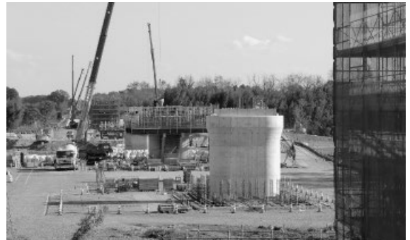
写真2 鬼怒川を渡る鬼怒川橋梁では橋脚を建設中
