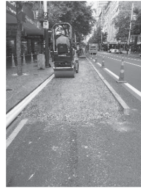
写真7 ロックダウンの段階的解除に向けて、歩道の拡幅工事を実施しているオークランド（ニュージーランド） [13]
