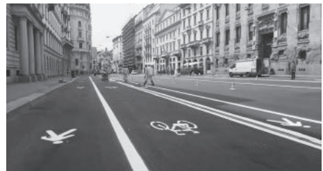
写真8 イタリア・ミラノで、車道を潰して歩道の拡幅と自転車レーンを整備している様子 [14]
