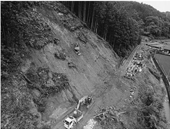
写真2 内子線 斜面崩壊復旧工事の様子(7月15日) https://twitter.com/JRshikoku_tokyo/status/1283643596109803520
