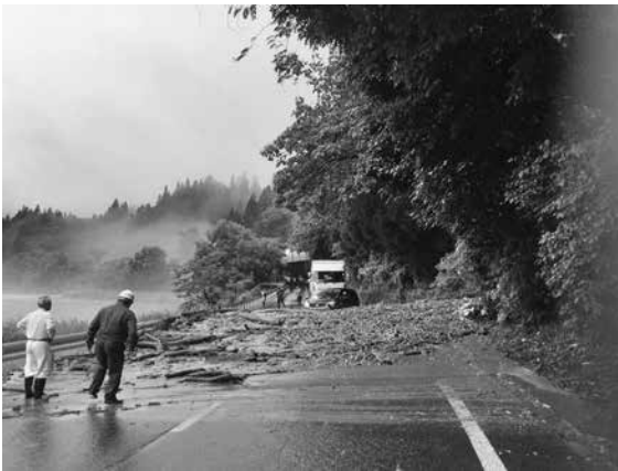
写真3 只見線 並行する国道の法面崩壊(7月31日) https://twitter.com/JRE_Tohoku_A/status/1289092541300654082
