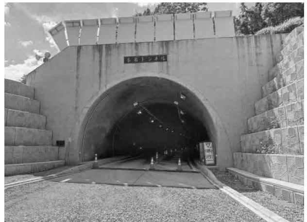
国道252号 本名バイパス 本名トンネル入口(供用前)
