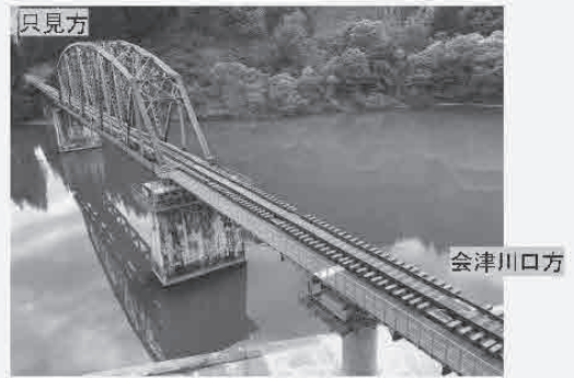
桁架設完了・軌道工事施工中
