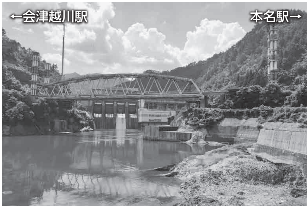
只見川を渡る只見線・第6只見川橋梁(中央)と本名ダム(奥)
