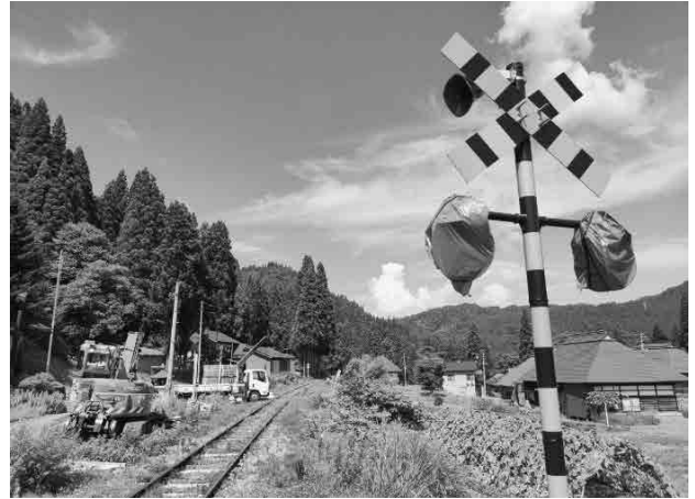
交換された踏切警報器と軌道作業車(本名駅)
