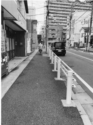
フラットになり、車道と歩道の間 ポールが設置された歩道。
