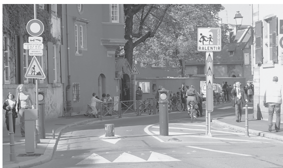
写真F：フランス、ストラスブールの小学校前の道路に設置されたライジング・ボラード
