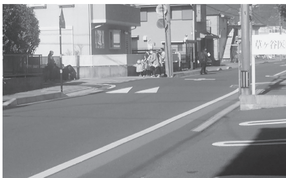
写真E：静岡県静岡市清水区、入江小学校の通学路交差点ハンプが写真左側の横断歩道外側まで延長されスムーズ横断歩道を構成している。
